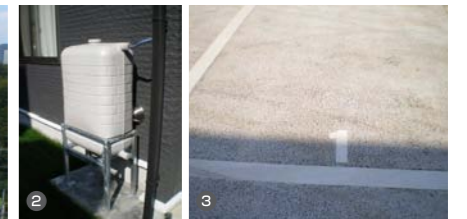
①太陽光発電：太陽光発電パネルを屋上に設置することで日中の電力をまかないます。②雨水の貯水タンク：200ℓ（およそ 20 分のシャワー使用量と同じ水量）を貯水できます。③保水性舗装：実用化されればヒートアイランド対策に効果があるとされる舗装技術です。
