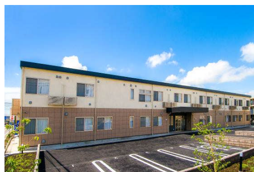
あずみ苑勝田台 外観
