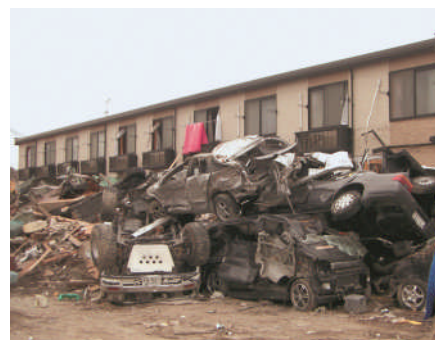
津波により流された建材、自動車等をせき止めている当社管理物件
