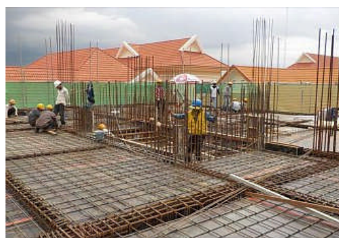
建設中のサービスアパートメント(カンボジア)
