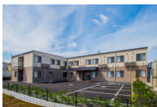
あずみ苑鎌ヶ谷 外観
